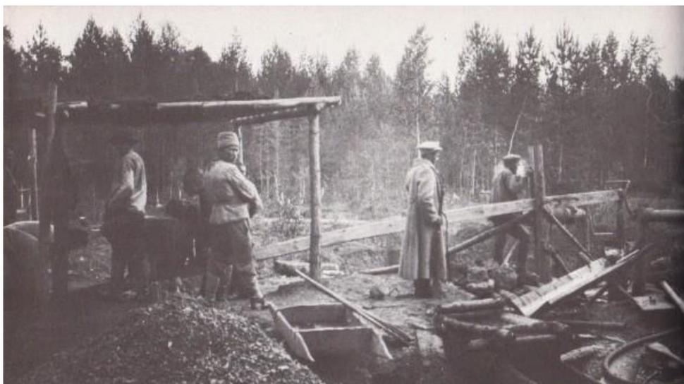
Рис. 11. Ворота над «Открытой шахтой». Справа лоток для промывки грунта.
