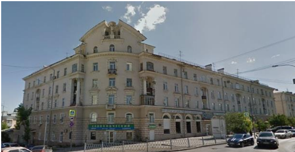
Рис. 15. Каменный пятиэтажный жилой дом с магазинами
