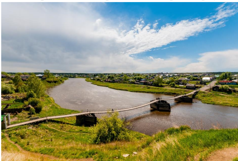
Рис. 16. Подвесной мост через реку Тура. Фото Дмитрия Карпунина. 2018 г.
