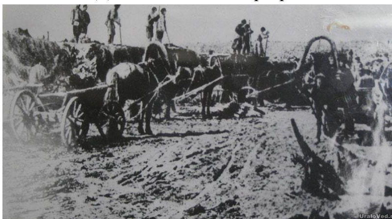
Рис. 8. Карьер 86 Вознесенского рудника. Вскрышные работы, 1902 г.
