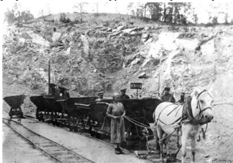
Рис. 9. Конная откатка вагонеток с Нижней станции, начало XX века
