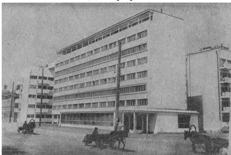
Рис. 4. Дом Гинзбурга на перекрёстке Малышева-Хохрякова
