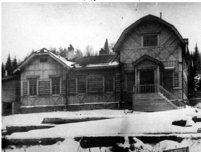
Рис. 16. Главное здание станции «Востряк», пос. Уралец (фото 1926 г.)
